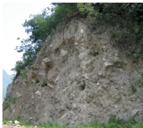
图1 实际的土石混合体边坡图像
